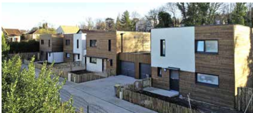
1 er programme de 4 maisons passives certifiées de l'Essonne et inauguré en mars 2019. Grâce aux éco-matériaux, les maisons sont classées E2-C2 et pourront facilement passer en E3 avec des panneaux photovoltaïques (Cep= 30 kWh/m 2 .an). Réal. : Green Eco-Promotion
